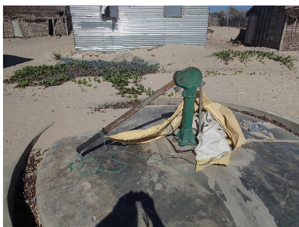
Pompe manuelle pour le remplissage du réservoir d'eau
