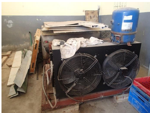
Compresseur pour la fabrication de glace
