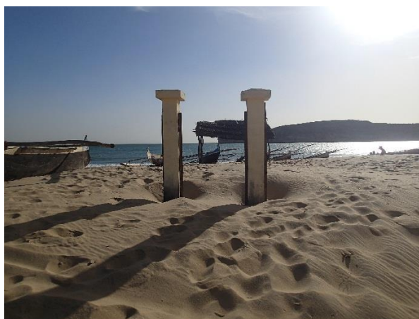
Piliers de la clôture enfouis dans le sable
