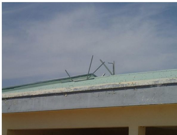
Panneaux solaires transférés chez Blue Venture
