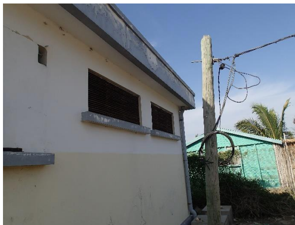
Branchement de la JIRAMA à 1m du débarcadère
